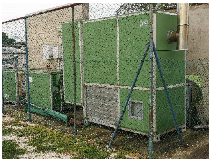
Figura 1- Generatore d'aria calda esistente
